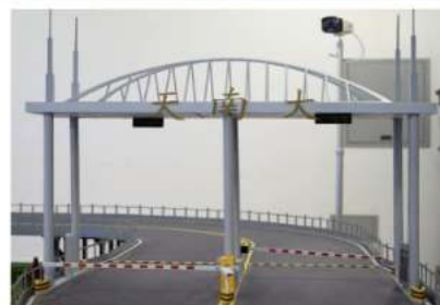
闸机入口与匝道
